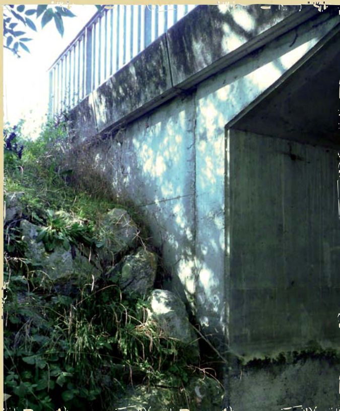
Le pont avant travaux
