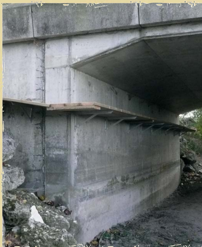
Début des travaux pour le passage à Vison
